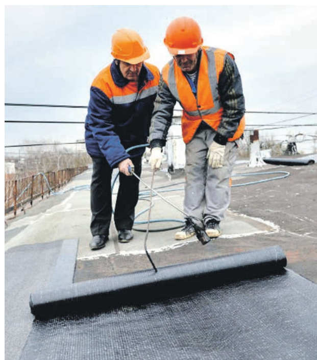
Кровлю заменят по просьбе жильцов. Высотные работы специалисты проведут с соблюдением всех норм безопасности
