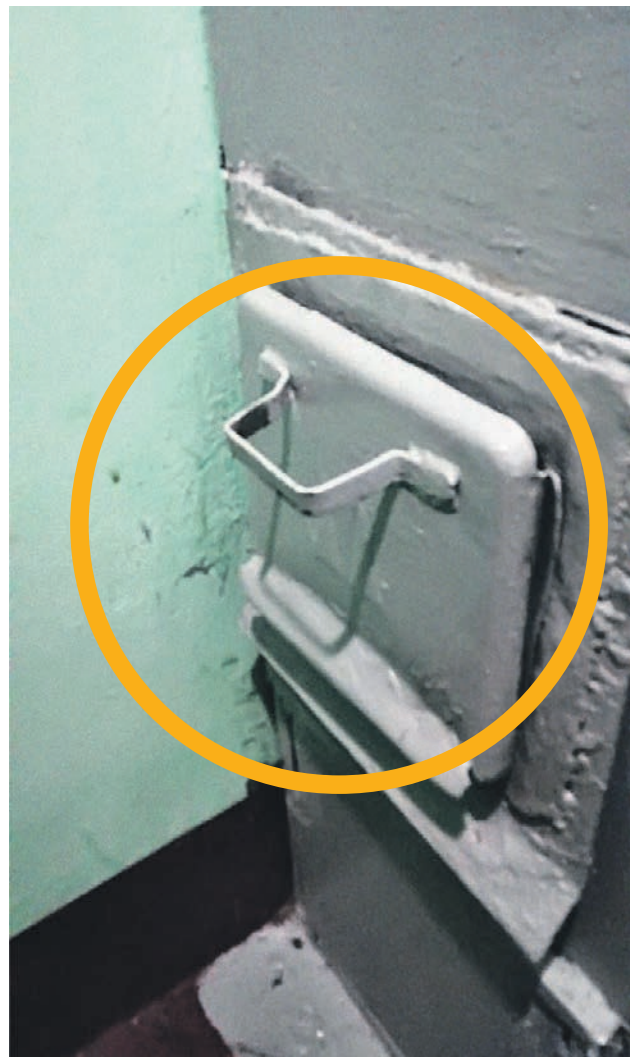
Ковш мусоропровода починили и покрасили. Теперь он плотно закрывается
