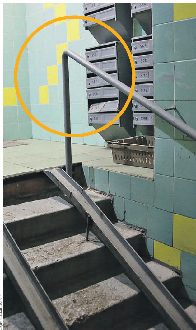
Для удобства старшего поколения на лестнице в подъезде установили поручни
