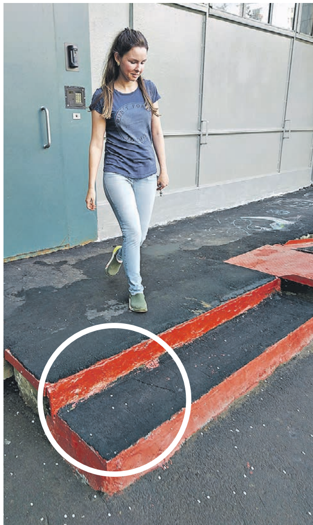
По просьбе жильцов покрытие ступенек заменили на асфальтовое
