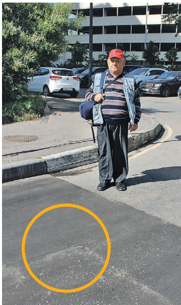
Сотрудники коммунальной службы уложили новый асфальт на месте ямы
