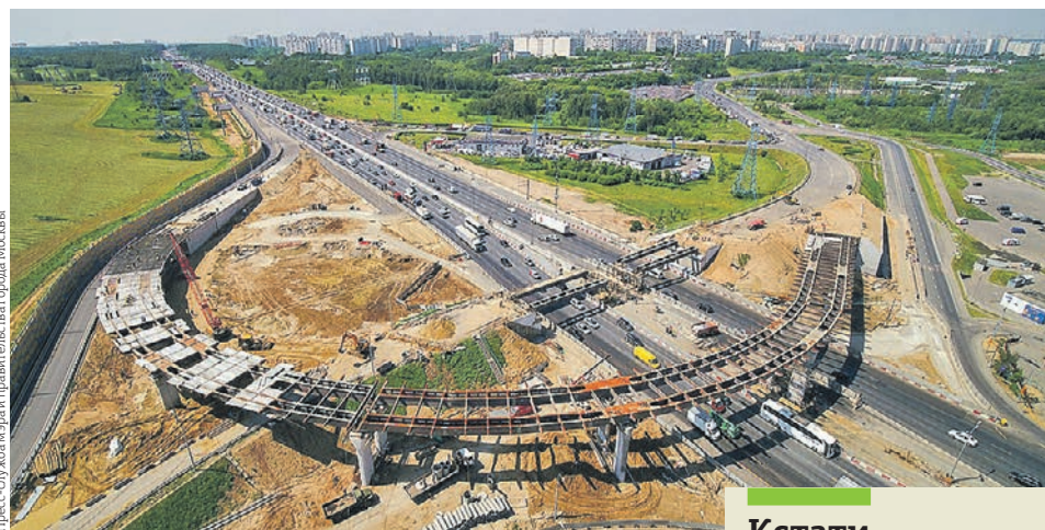
Строительство на пересечении Московской автодороги и Бесединского шоссе завершили на 50 процентов
