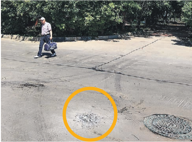
Рабочие демонтировали старую конструкцию и заделали образовавшуюся дыру
