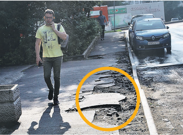
Рабочие сняли рядом с домом старое покрытие, но новый асфальт не положили
