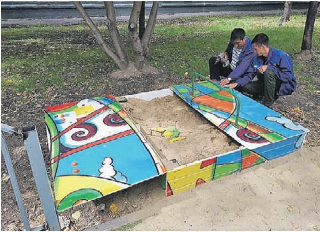
Работы по замене петель щитов в песочнице на площадке выполнили оперативно
