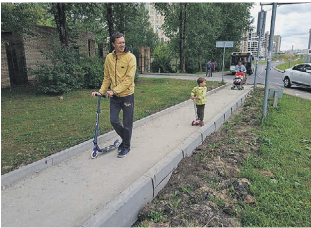
Ремонт пешеходной дорожки на въезде в микрорайон Солнцево Парк завершат до конца июля
