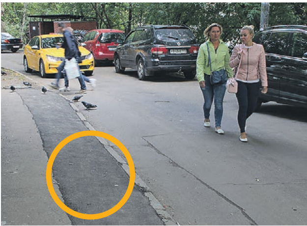
Выбоины и трещины на пешеходной дорожке во дворе заасфальтировали
