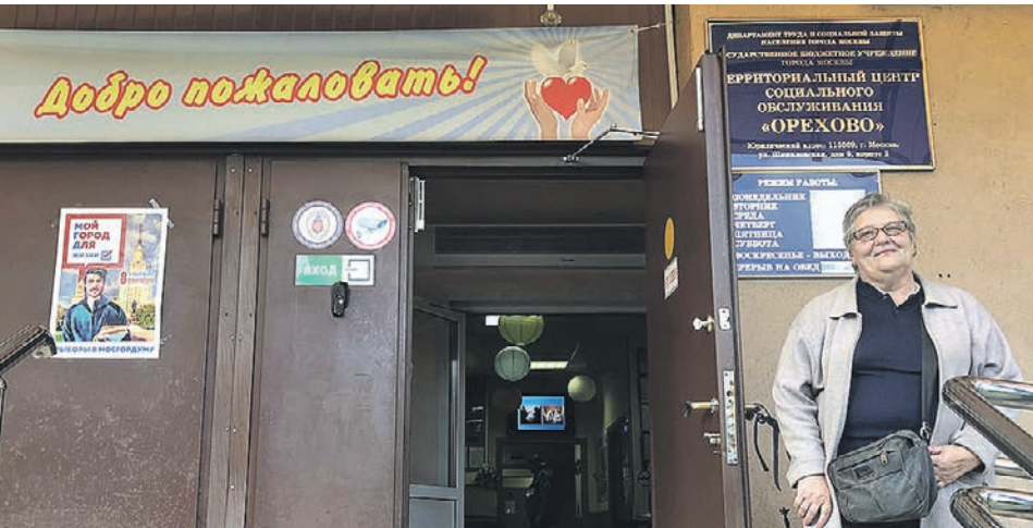
Жительница района Ольга Всеволодовна считает, что ремонт зданию нужен
