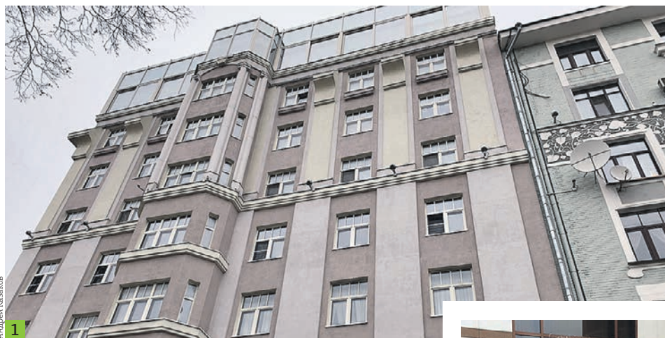
Стены дома реконструируют, а фасады покрасят (1). Николай Жук (2)
