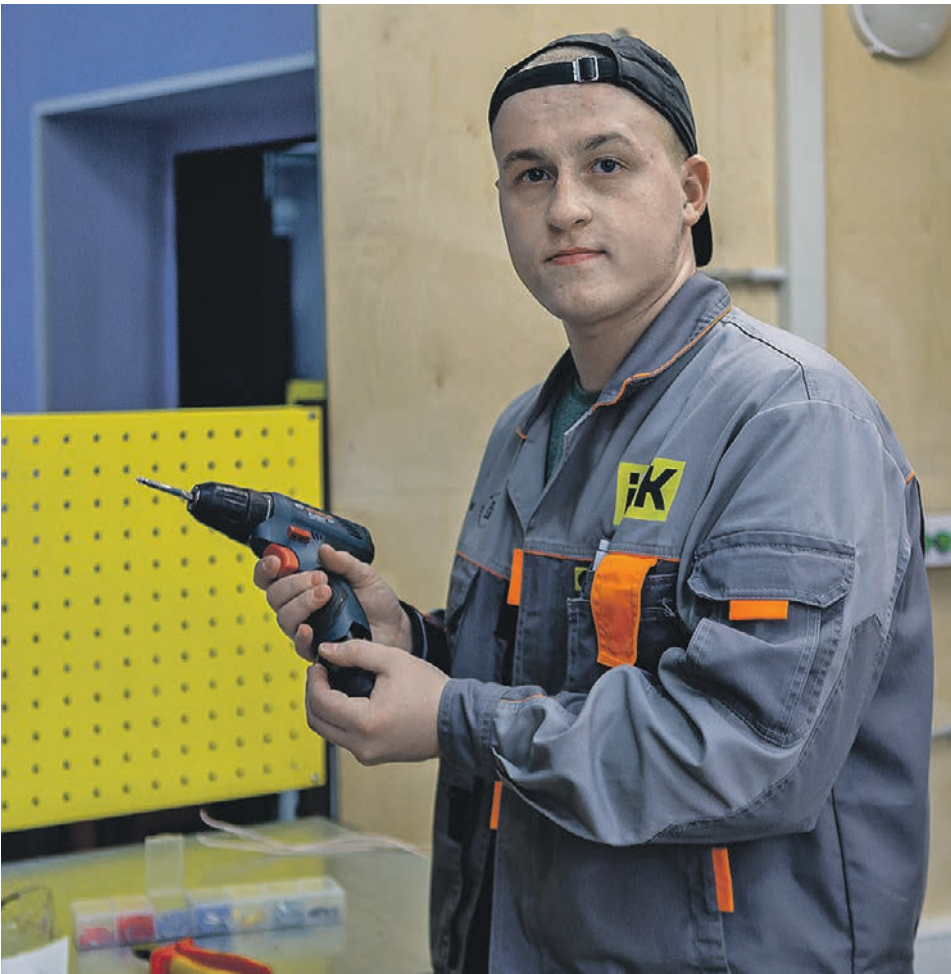
Студент третьего курса Матвей Медведев производит монтаж электрического щитка
