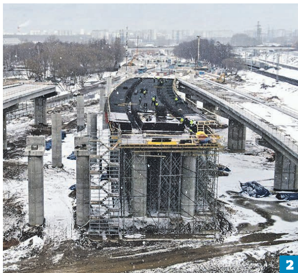
22 марта 2021 года. Строительные работы развернуты на всех десяти участках Юго-Восточной хорды (1) Девятый участок готов на 36 процентов (2)
