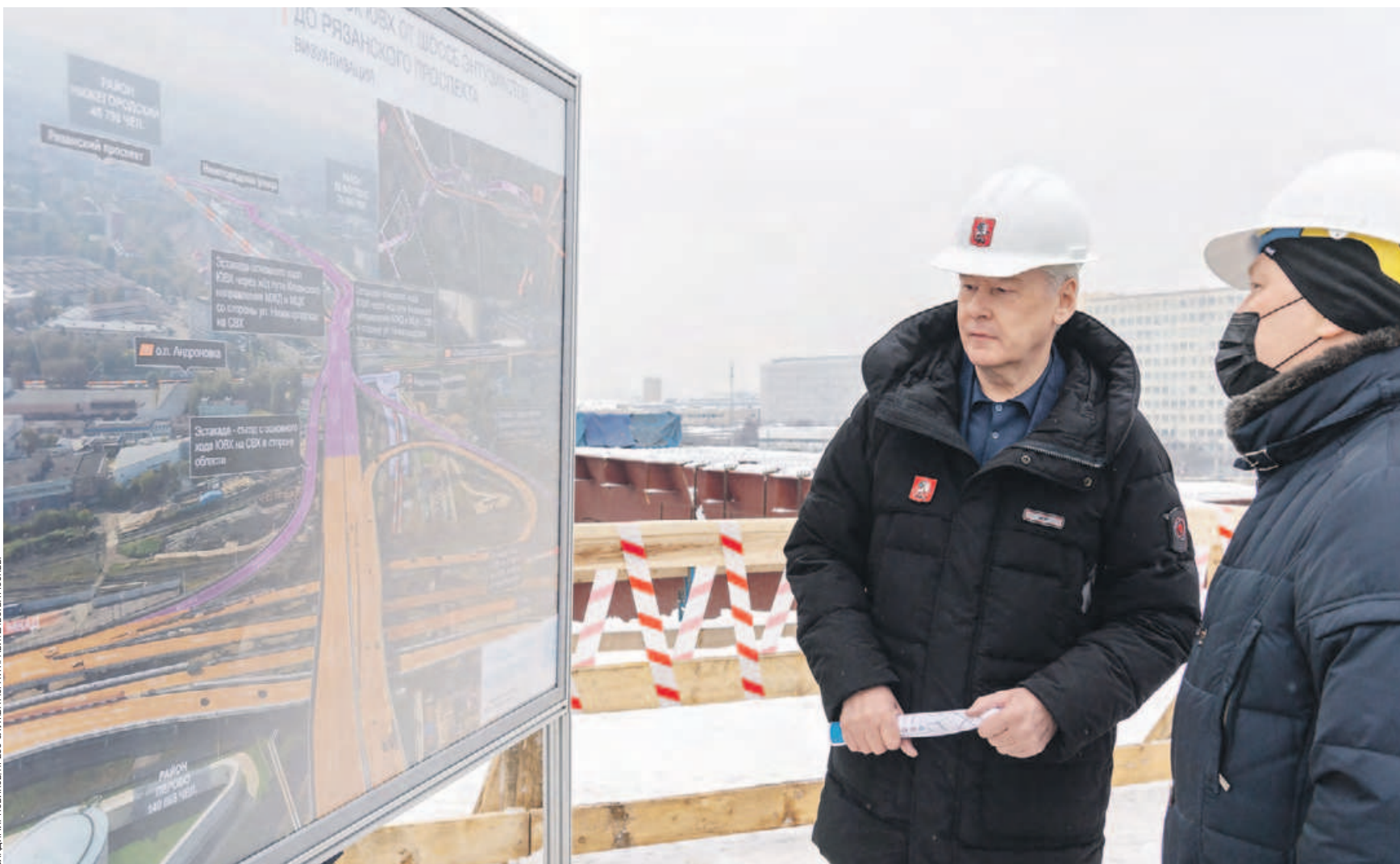
Вчера 13:13 Мэр Москвы Сергей Собянин (слева) и заместитель мэра столицы по вопросам градостроительной политики и строительства Андрей Бочкарев во время осмотра хода работ на Юго-Восточной хорде. Участок от шоссе Энтузиастов до Рязанского проспекта готов уже наполовину
