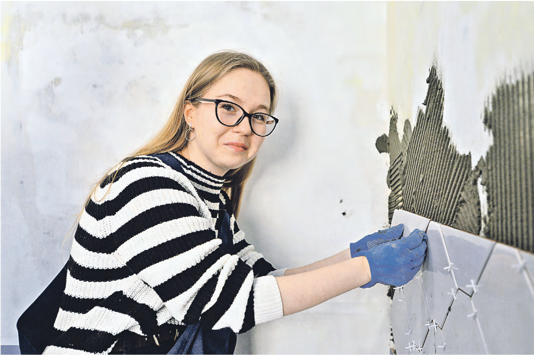
6 апреля. Юнкор Анна Тыбинь укладывает первую в своей жизни плитку. В такой работе важны аккуратность и внимание к деталям
