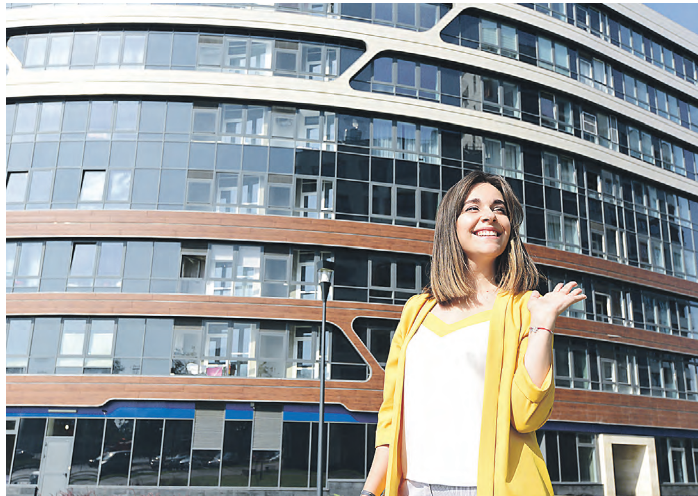
10 сентября 2019 года. Москвичка Екатерина Соловей на фоне жилого комплекса неподалеку от станции Серп и Молот. Строительству корпусов началось в 2017 году, но квартиры там до сих пор не распроданы
