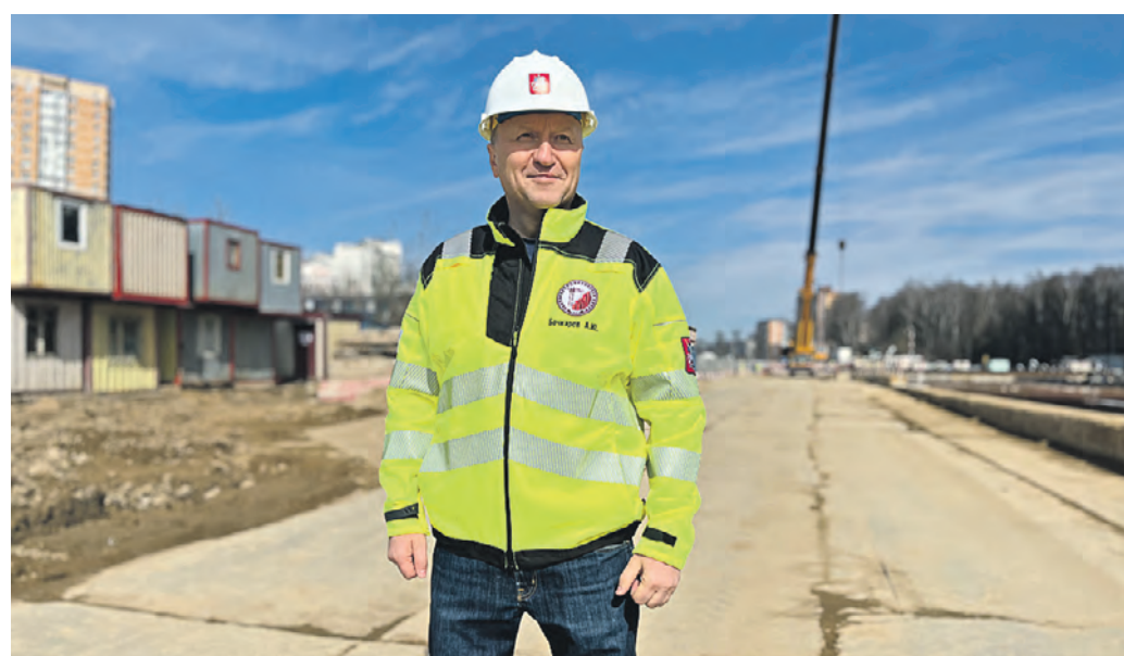
8 апреля 11:39 Заместитель мэра Москвы по вопросам градостроительной политики и строительства Андрей Бочкарев на строящейся станции метро «Физтех»
