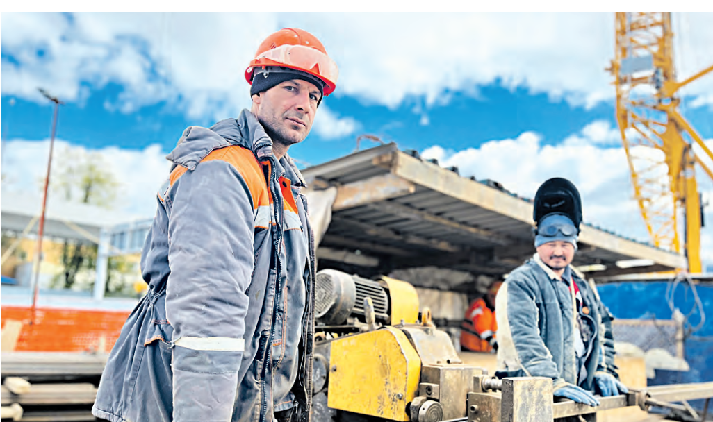
6 мая 11:32 Арматурщик Федор Муравьев (слева) и сварщик Султан Байбусинов в составе бригады возводят станцию «Аэропорт Внуково» Солнцевской линии метро
