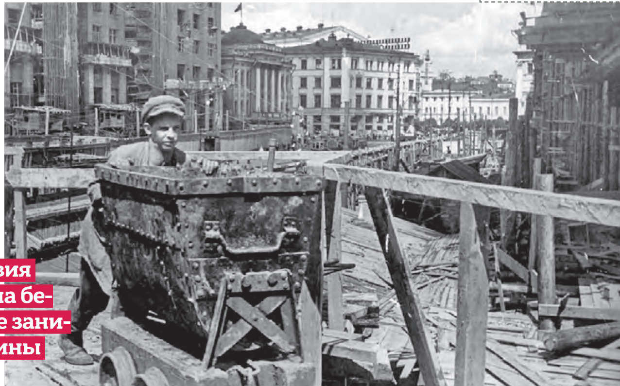
Июль 1934 года. Строительство метро «Охотный ряд». Эстакада для подъема вынутого грунта на поверхность
