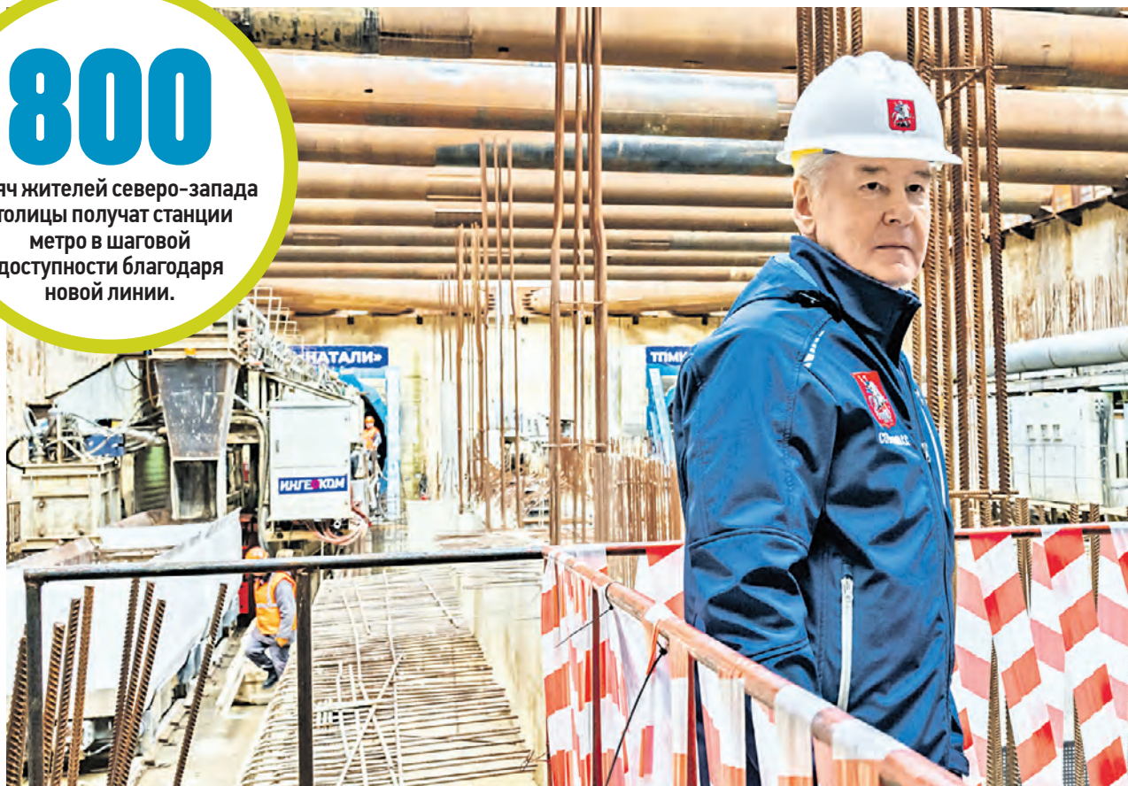
15 мая. Сергей Собянин дал старт проходке тоннелей от станции «Народное Ополчение» до станции «Бульвар Генерала Карбышева»
