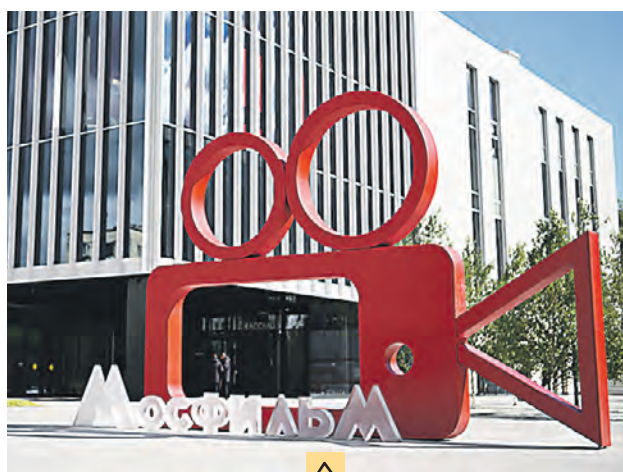
Новое здание киноконцертного комплекса «Мосфильм», построенное в 2022 году
