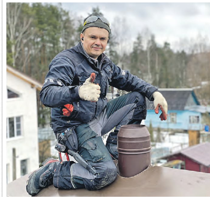
Март 2023 года. Трубочист Александр Колесников отремонтировал дымоход
