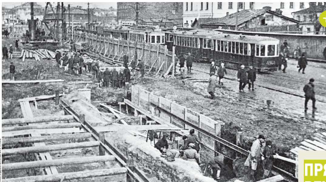
Открытая проходка шахты № 26 на Верхней Красносельской улице при строительстве метрополитена в Москве. Фото 1933 года
