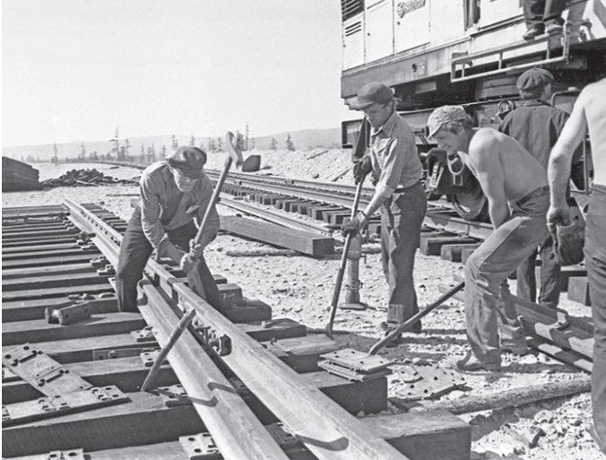
1 июля 1976 года. Строительство Байкало-Амурской магистрали в районе поселка Могот Тындинского района
