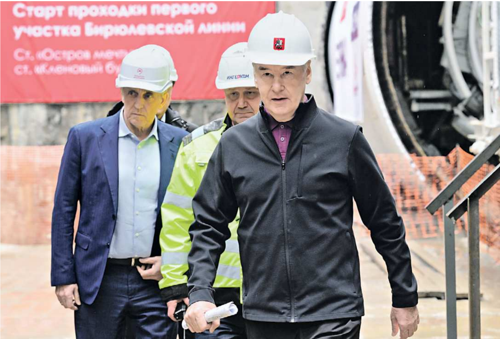
18 июня. Мэр Москвы Сергей Собянин (на первом плане), президент АО «Объединение «Ингеоком» Дмитрий Евсеев (за мэром) и начальник Московского метрополитена Виктор Козловский дали старт проходке щита на участке Бирюлевской линии между станциями «Остров Мечты» и «Кленовый бульвар»
