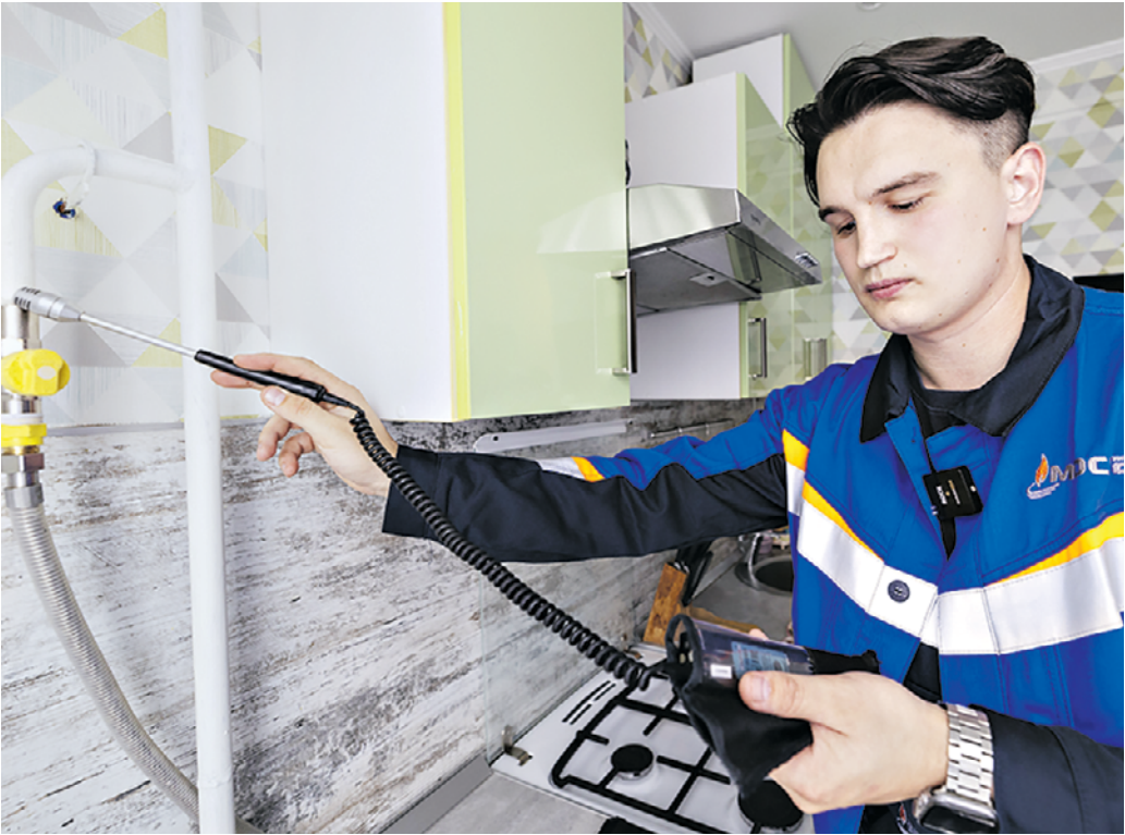
19 января. Слесьярь по эксплуатации и ремонту газового оборудования АО «Мосгаз» Сергей Эпштейн проверяет герметичность соединений элементов газопровода в московской квартире
