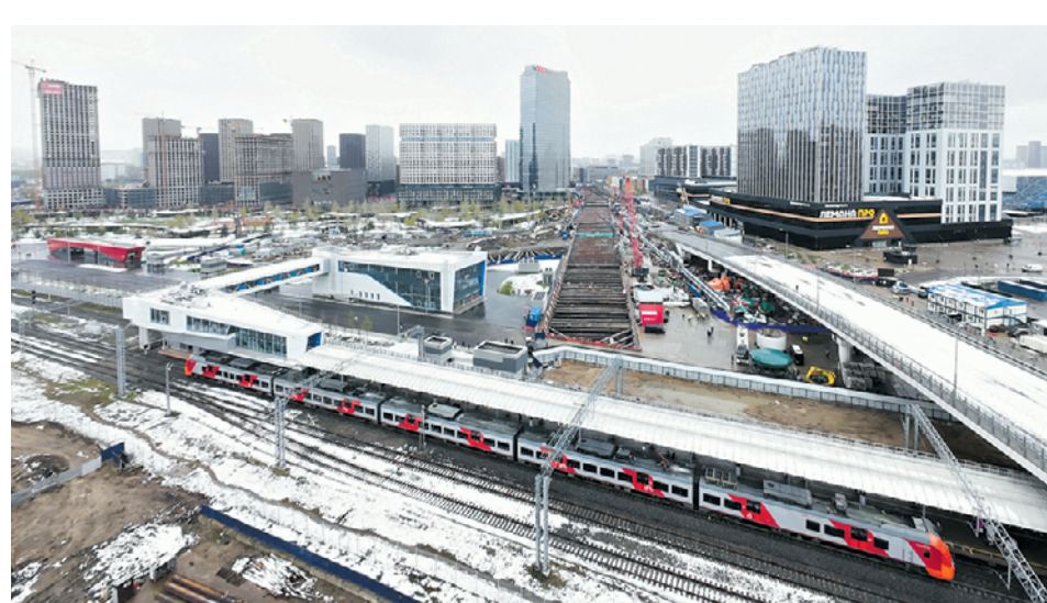
Территория строящейся станции Бирюлевской линии московского метро
