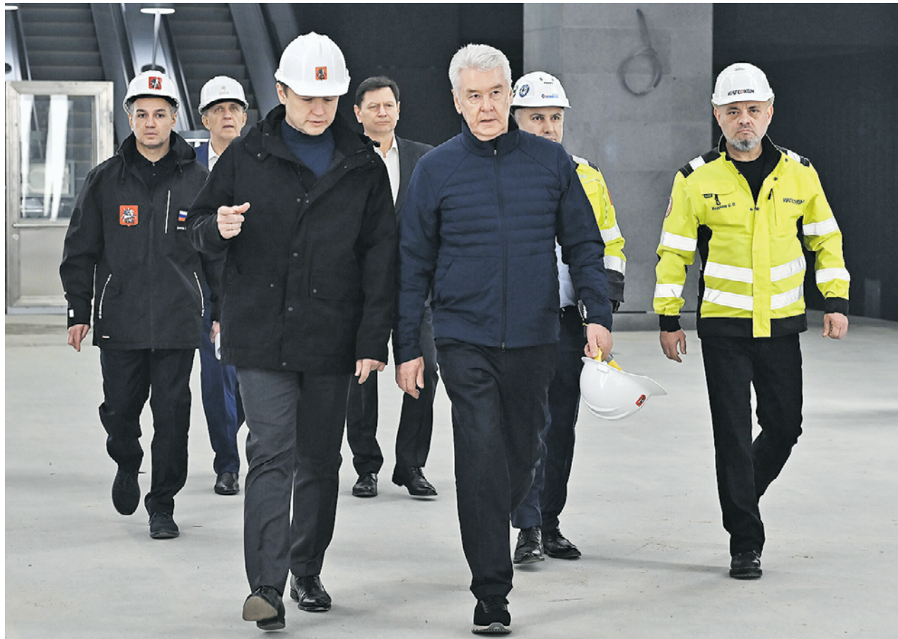
1 апреля. Мэр Москвы Сергей Собянин (в центре) и его заместитель по вопросам градостроительной политики и строительства Владимир Ефимов (на первом плане слева) оценили ход строительства станции «Народное Ополчение»
