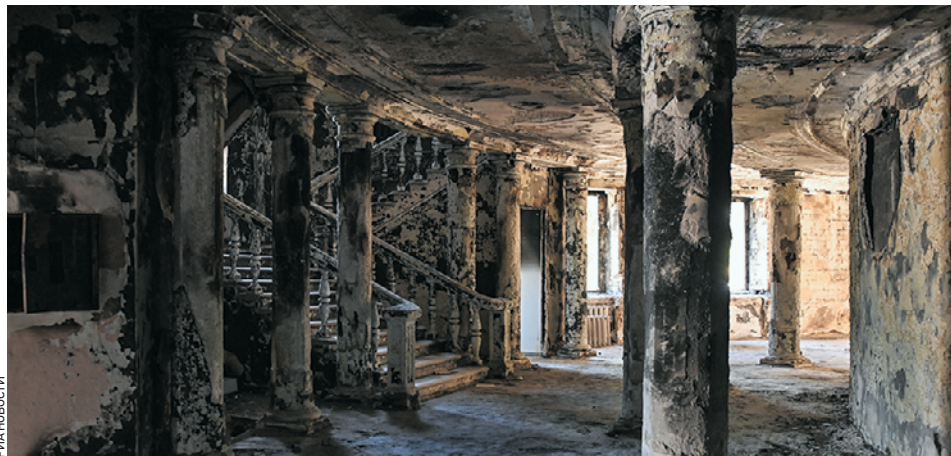
18 июля 2022 года. Здание Академического областного театра в Мариуполе было фактически полностью разгромлено
