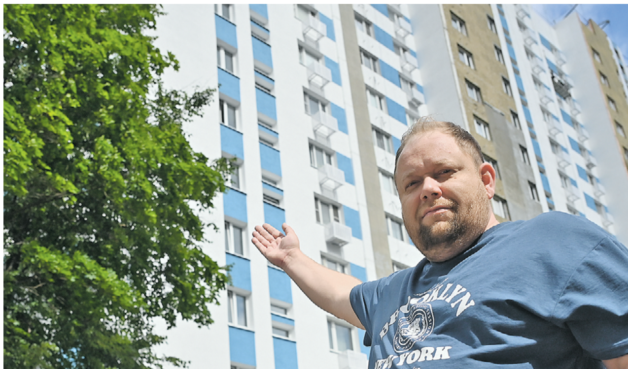
17 июня. Начальник управления капитального ремонта ГБУ «Жилищник района Орехово-Борисово Южное» Алексей Никитин демонстрирует фасад жилого дома в Гурьевском проезде, где проводится капитальный ремонт. ФОТО: АЛЕКСАНДР КОЧУБЕЙ
