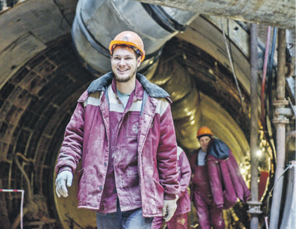
1 октября 10:30 Метростроевец Дмитрий Маручков работает на глубине 40 метров. Он в составе бригады сооружает тоннель от «Стромынки» до «Рубцовской»
