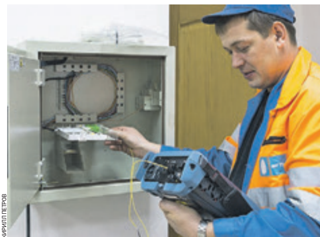
Работа с оптикой предъявляет повышенные требования к квалификации монтажника
