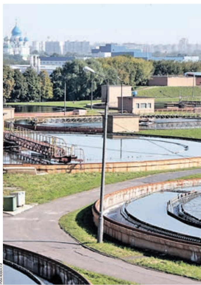
Вчера 13.40 Очистка воды на Курьяновских сооружениях благодаря новейшим технологиям — экологически чистый процесс
